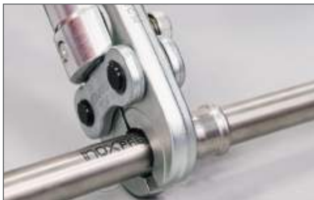
Assemblaggio attraverso pressatura / Making the press connection
