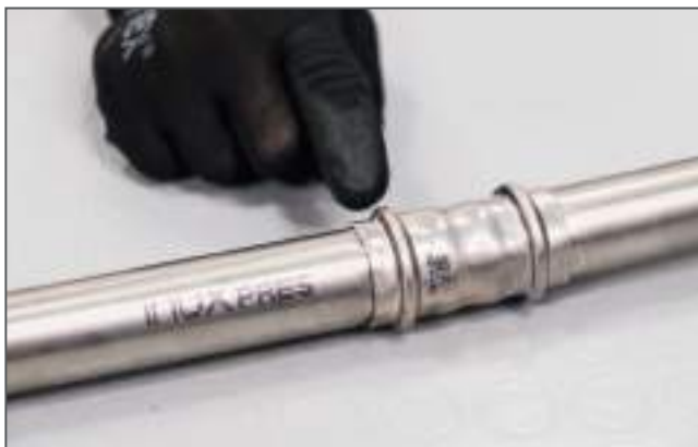
Controllo della pressatura / Checking the press connection
