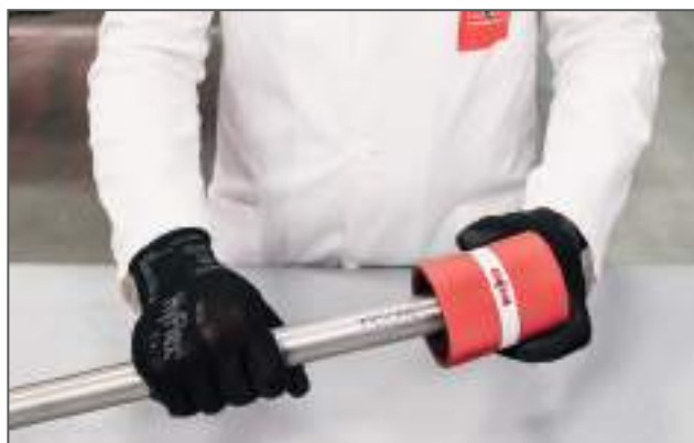
Sbavatura del tubo / Deburring the pipe
