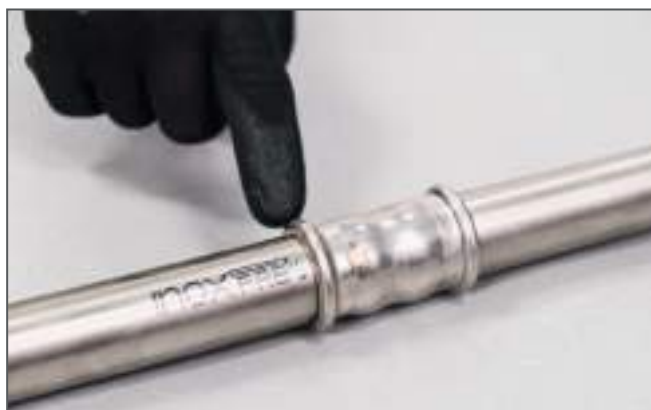
Controllo della pressatura / Checking the press connection
